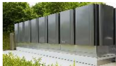
Un'altra tecnologia con celle a Sistema SOFC (Convion, 50 kW)
