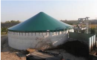
Copertura di vasca di stoccaggio
