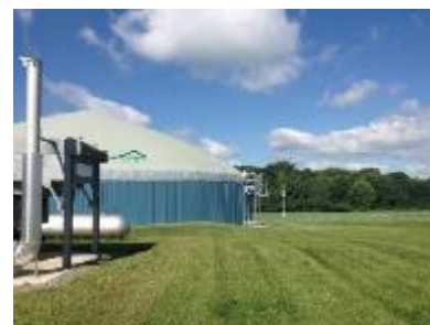
Un impianto biogas CMA
